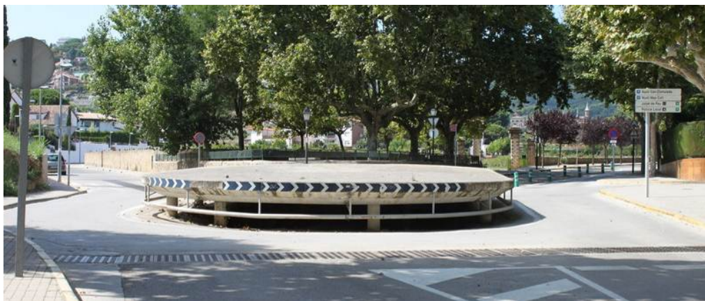
Fotografia 3. Engolidor al mig del carrer de la riera de Coma Fosca.
