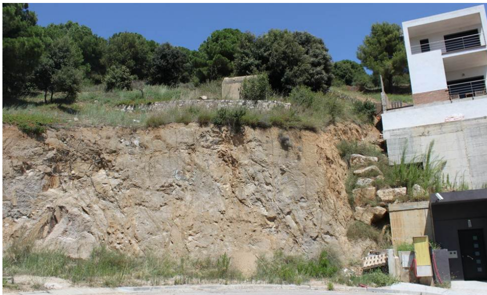
Fotografia 10. Exemple de talús excavat en sauló al carrer del Berguedà en el nucli de Mas Coll
