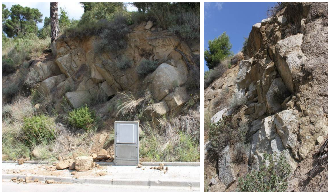
Fotografia 22. Detalls dels desprendiments del talús de l'avinguda Sant Mateu de Can Magarola
