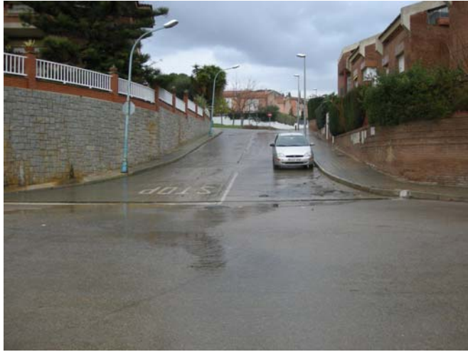
Foto 1. Vista del torrent aigües amunt, en la zona urbanitzada
