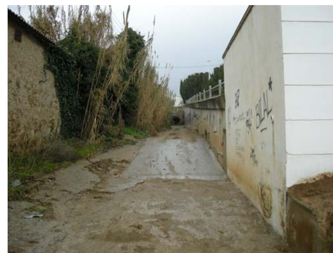
Foto 8. Vista del tub de 2.000 mm de diàmetre a la sortida del pas sota la fàbrica
