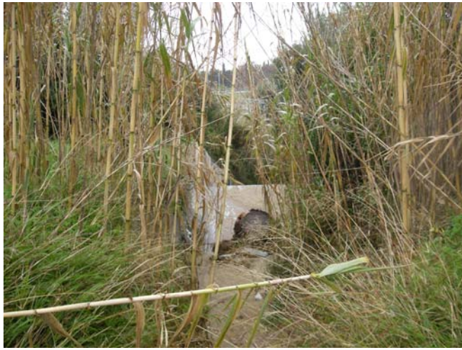
Foto 1. Vista del torrent aigües avall, des del camí
