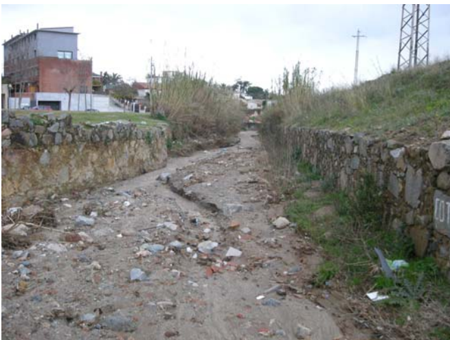
Foto 2. Vista del Torrent després del pas de l'autopista
