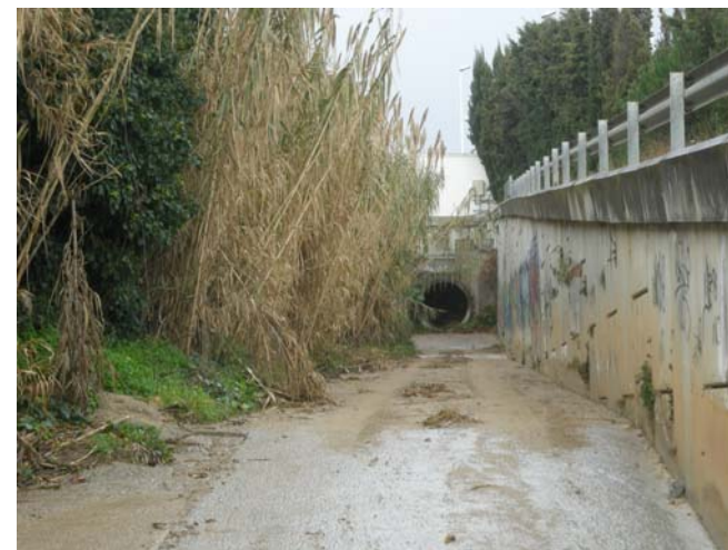
Foto 7. Vista del tub de 2.000 mm de diàmetre a la sortida del pas sota la fàbrica
