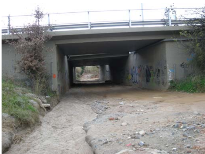
Foto 5. Vista del pas de l'autopista aigües amunt
