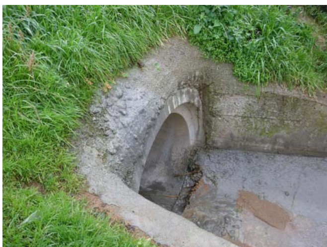
Foto 10. Vista del col·lector de 1000 mm que connecta amb el torrent Sisters
