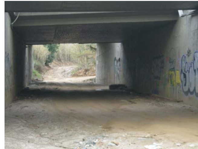
Foto 4. Vista del pas de l'autopista, aigües amunt
