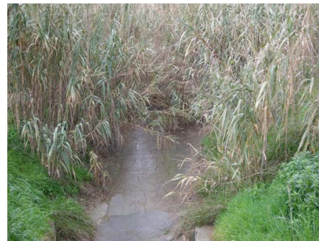
Foto 11. Vista del torrent després de passar l'autopista
