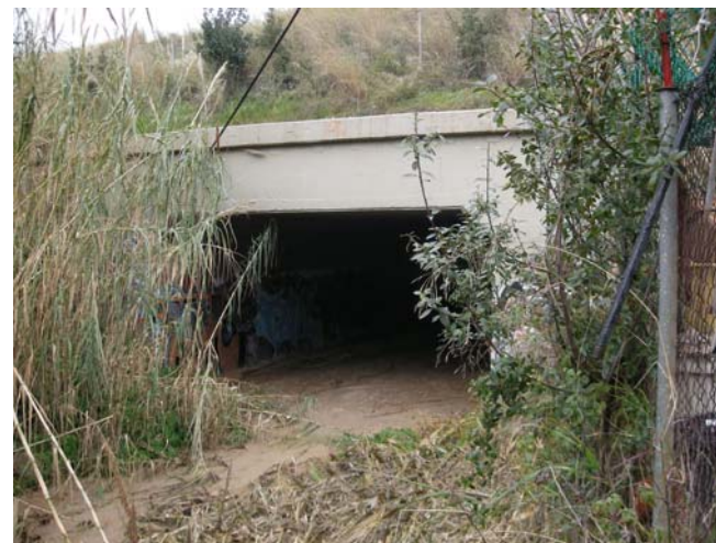
Foto 7. Vista de la obra de pas de l'autopista
