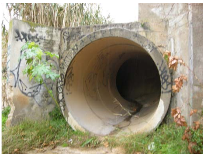
Foto 6. Vista del tub de 2.000 mm de diàmetre a la sortida del pas sota la fàbrica
