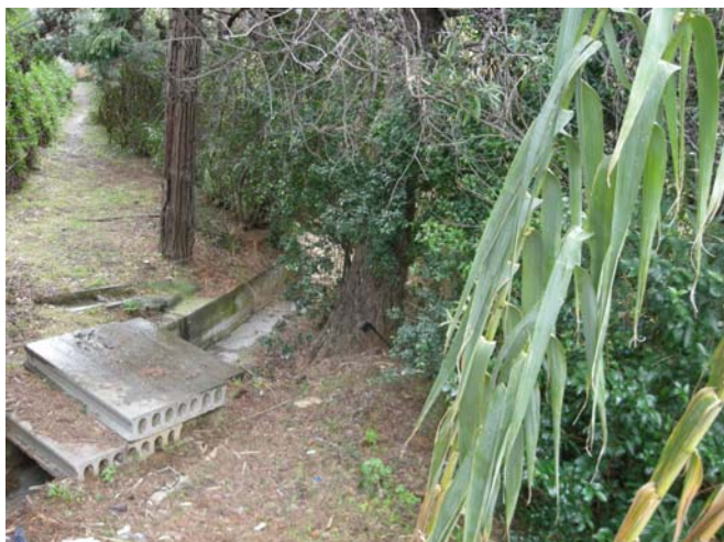
Foto 13. Connexió del torrent amb el torrent Sisters
