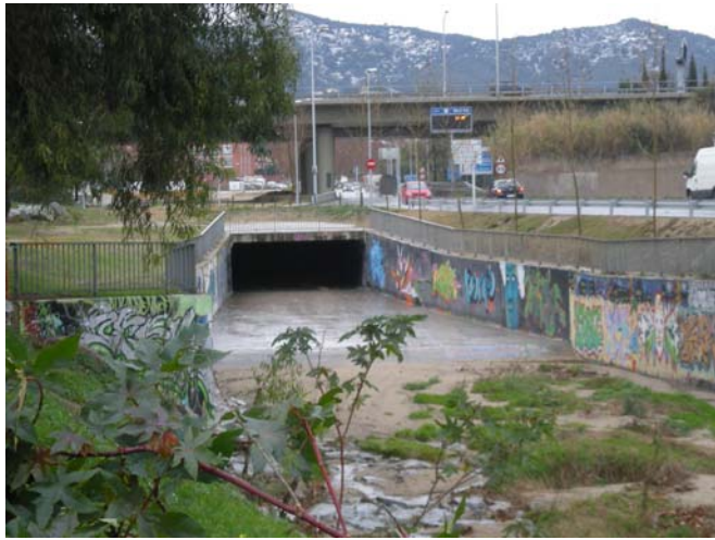
Foto 1. Vista de l'endegament de la riera
