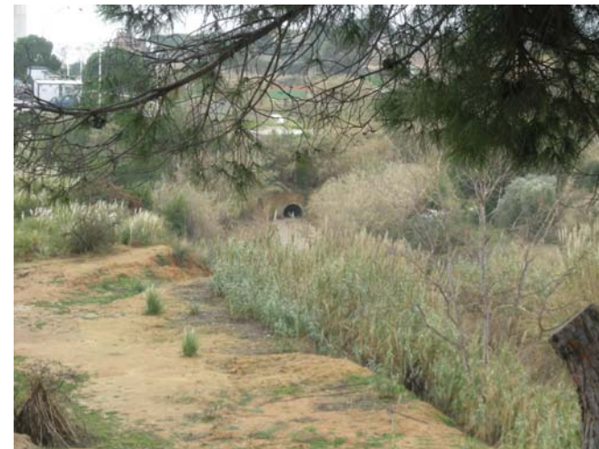
Foto 4. Vista de la obra de pas sota la fàbrica
