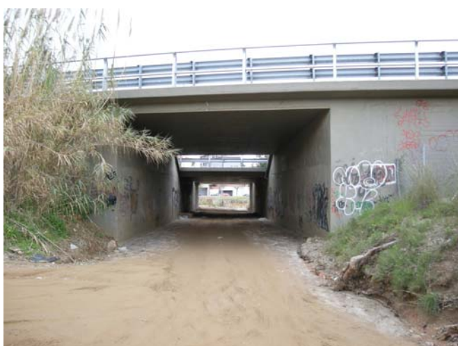
Foto 6. Vista del pas de l'autopista aigües amunt
