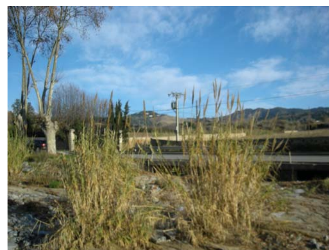
Foto 8. Vista de la incorporació del Torrent a la riera d'Alella
