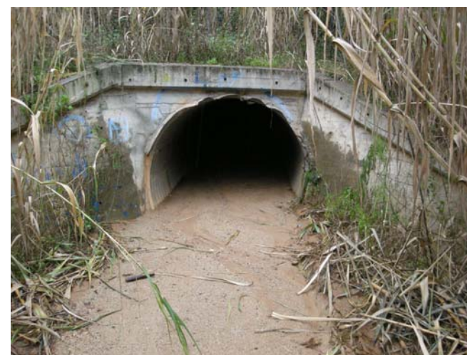
Foto 12. Vista del pas de l'autopista. Tub arc de 2000 mm
