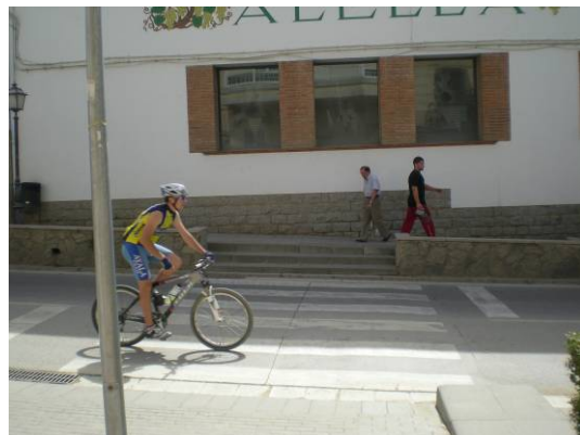
Imatge 13. Avinguda Àngel Guimerà. Un pas de vianant acaba en una escala. Existeix un pas accessible a uns 70 metres.
