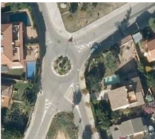
Imatge 20. Intersecció entre el Camí del Mig, carrer Charles Rivel i el Creu de Pedra. El radi d'entrada/sortida és massa gran, i no s'obtingui una bona reducció de la velocitat.
