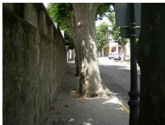
Imatge 15. Riera Fosca. Els arbres al ple mig de la vorera també impedeix el pas de vianants.
