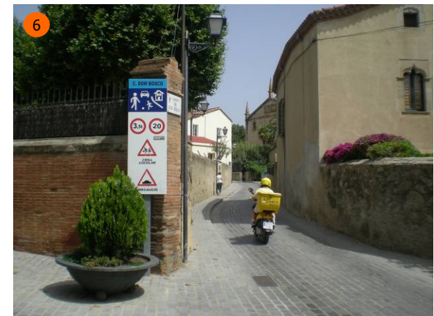
C. Don Bosco, carrer residencial. Tot i haver disposat paviment únic, s'ha mantingut en una alçada sobre-elevada una vorera, contradint la definició mateixa de l'establiment de paviment únic. Aquesta característica s'observa en gran part del paviment del nucli urbà.
