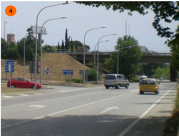
Vista dels vehicles de sortida del peatge. Del carril d'incorporació els vehicles passen al carril de la BP-5002 direcció mar.
