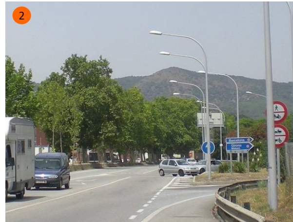
Gir d'entrada al peatge pels vehicles circulant per la BP-5002 sentit mar. Aquest vehicles disposen d'un carril d'espera. En el gir creuen les trajectòries dels vehicles de sortida del peatge que s'incorporen a la BP-5002 sentit mar, i dels vehicles que circulen per la BP-5002 sentit muntanya.
