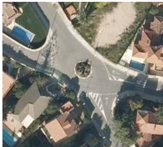
Imatge 21. Intersecció entre les avingudes Alella, Barcelona i Badalona. En aquest cas els radis també son massa grans i tampoc existeixen passos de vianants en tots els ramals.
