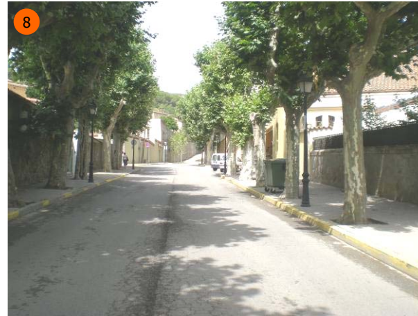
Vista de la secció general. Es constata que la calçada es troba sobre-dimensionada (7m), i no disposa de pintura de senyalització de carrils.
