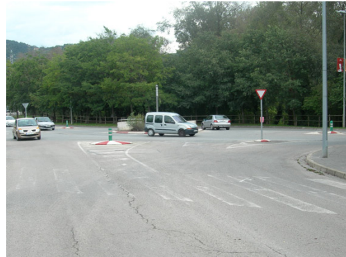
Senyalització horitzontal en estat deficient
