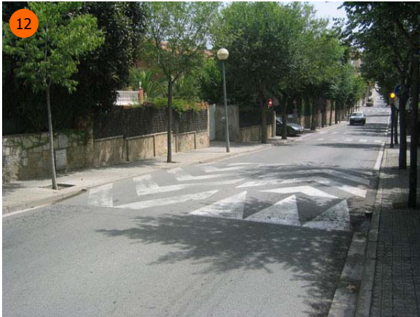
12 Plataforma reductora entre els carrers del Penedès i de l'Empordà.
