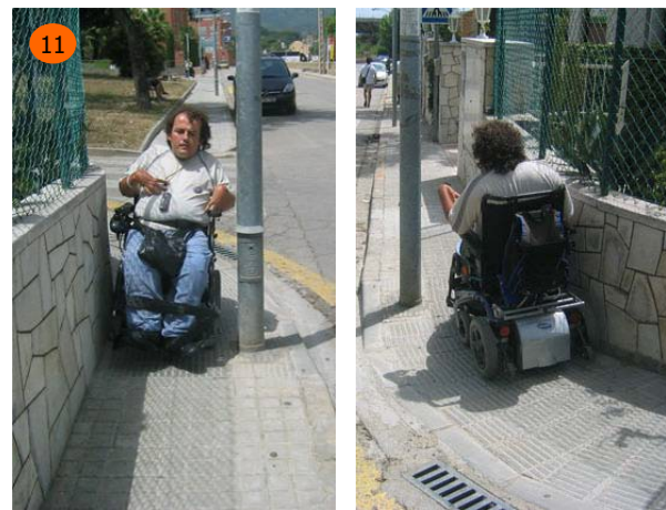
11 Vorera molt estreta que, amb el pal d'enllumenat queda en poc més de 0,60 m d'ample lliure. Aquest exemple no és buscat ad hoc, sinó que es tracta d'un usuari habitual d'aquest tram.
