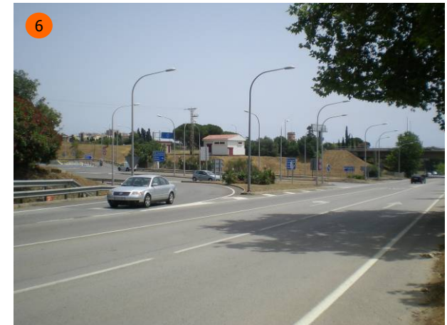
Ramal de sortida del peatge pels vehicles que s'incorporen a la BP-5002 sentit muntanya. L'angle del ramal dificulta la visibilitat dels vehicles de pujada per la BP-5002.
