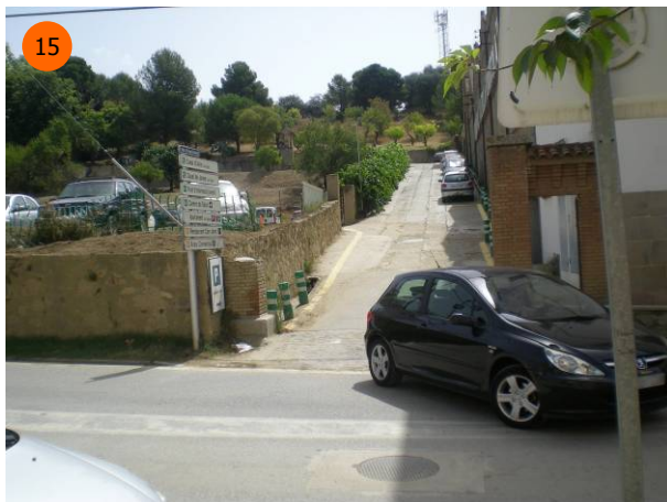
15 Sortida d'un vehicle de l'aparcament. S'observa l'escassa amplada de la via d'accés, que obligaria a un vehicle d'entrada a esperar parat a la Rambla abans d'accedir a l'aparcament. El vehicle de sortida realitza un gir a l'esquerra no obstant la senyalització horitzontal no ho permeti, i pugui ser un risc pels vehicles circulant a la Rambla.
