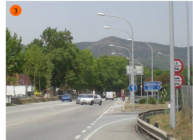
Incorporació a la BP-5002 sentit mar, provinents del peatge. Aquests vehicles disposen d'un carril d'incorporació. En el gir creuen les trajectòries dels vehicles d'entrada al peatge i dels vehicles que circulen per la BP-5002 sentit muntanya.
