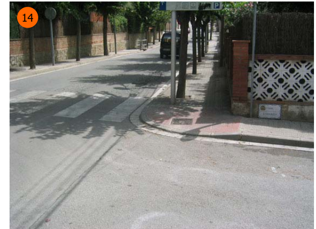
14 S'observen mesures d'adaptació d'itineraris per a vianants, però cal que el disseny s'estengui i tendeixi a homogeneitzar-se.
