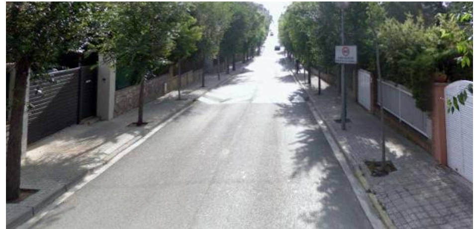
C. Guillerries, passat el c. Penedès. Traçat recte que facilita l'adopció de velocitats altes. Ara per ara, la velocitat es controla amb la presència del semàfor a la cruïlla amb el carrer P. Goleta Constància i amb la plataforma elevada entre Penedès i Empordà.
