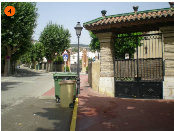
Carrer Riera Fosca. La configuració de la filera d'aparcament, i la disposició del mobiliari urbà, suposa un excessiu estrenyiment de l'amplada transitable de la vorera.
