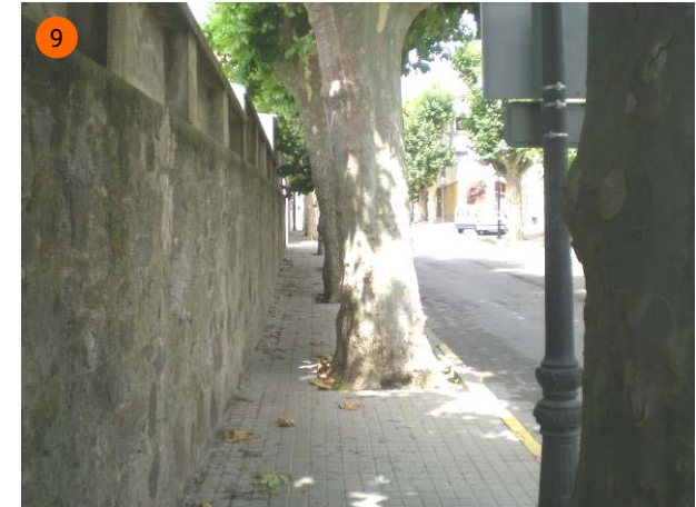
Tot i l'amplada de calçada, les voreres arbrades disposen d'una amplada útil inferior a la necessària per un desplaçament a peu còmode i segur. Detall de la vorera esquerra amb amplada útil de 60 cm.
