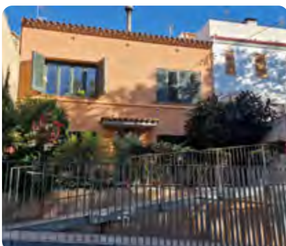
REHABILITACIÓ HABITATGE CASA DELS MESTRES 100.000€
