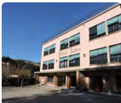
REFORMA EDIFICIS MUNICIPALS 100.000€
