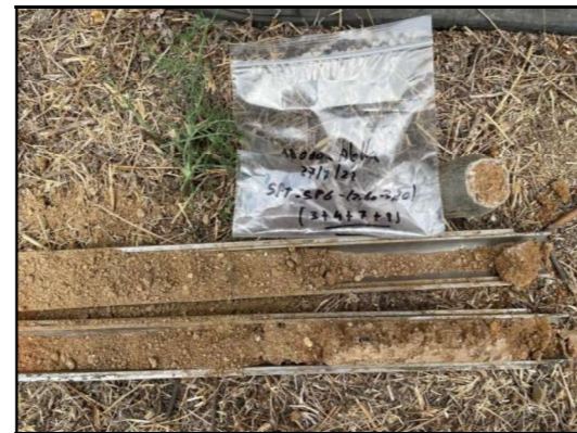
Foto 34: Sondeig Sp-6, SPT a 2,6 metres.
