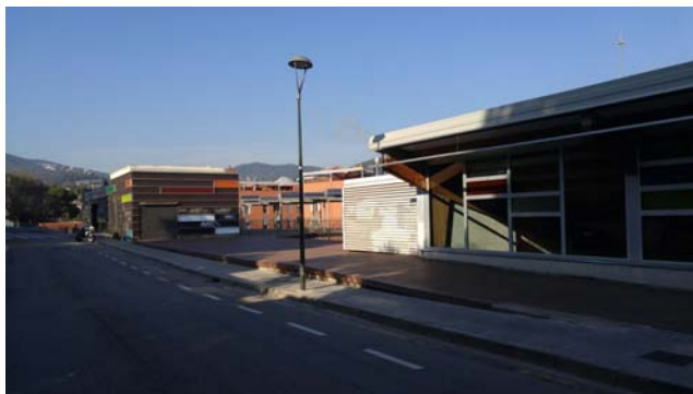
Ampliació sala gimnàs Pau Vila
