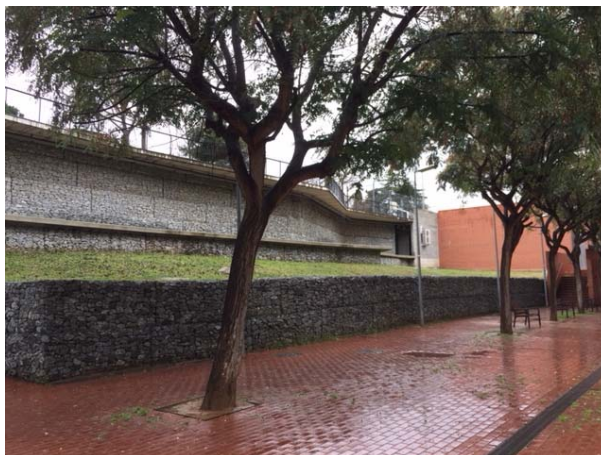
Nova caldera de Biomassa
