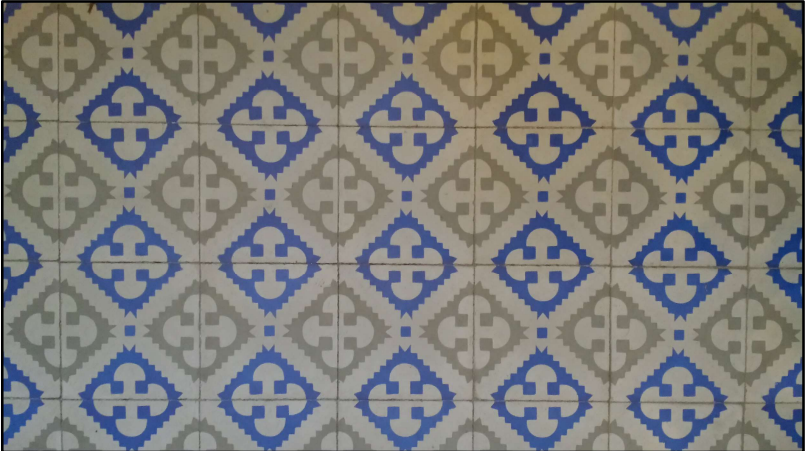
FOTO 7 DORMITORI 4 PAVIMENT HIDRÀULIC
