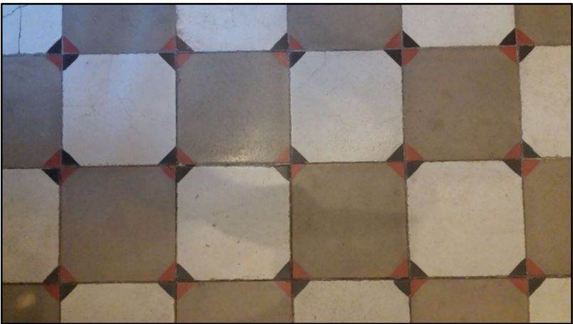
FOTO 6 VESTIDOR PAVIMENT HIDRÀULIC
