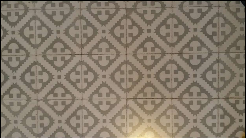
FOTO 4 DORMITORI 3 PAVIMENT HIDRÀULIC
