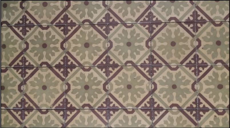
FOTO 8 MENJADOR PAVIMENT HIDRÀULIC
