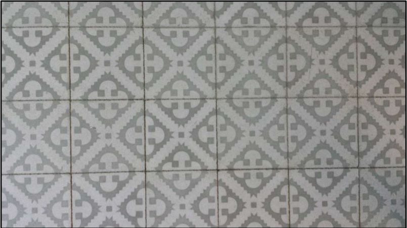
FOTO 4 DORMITORI 3 PAVIMENT HIDRÀULIC
