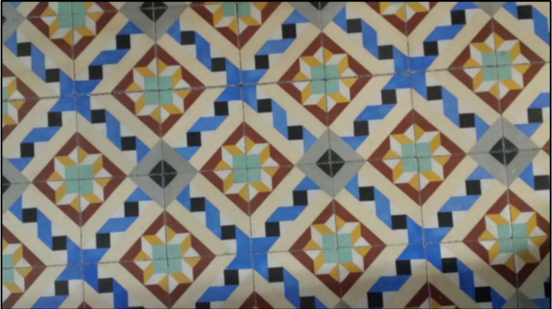
FOTO 5 REBEDOR PAVIMENT HIDRÀULIC
