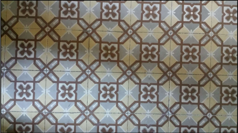
FOTO 8 MENJADOR PAVIMENT HIDRÀULIC
