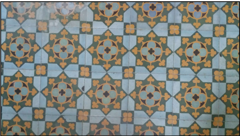
FOTO 6 BANY PAVIMENT HIDRÀULIC
