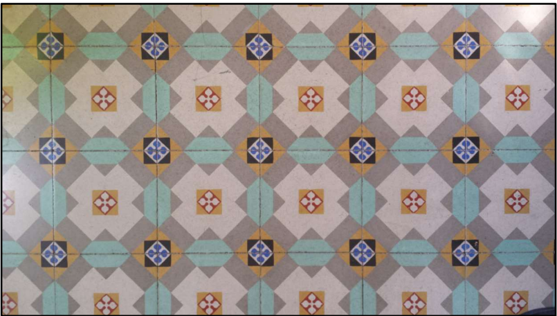
FOTO 1 DORMITORI 2 PAVIMENT HIDRÀULIC
