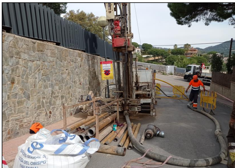
Realització d'una de les perforacions profundes amb instal·lació de tub piezomètric.
