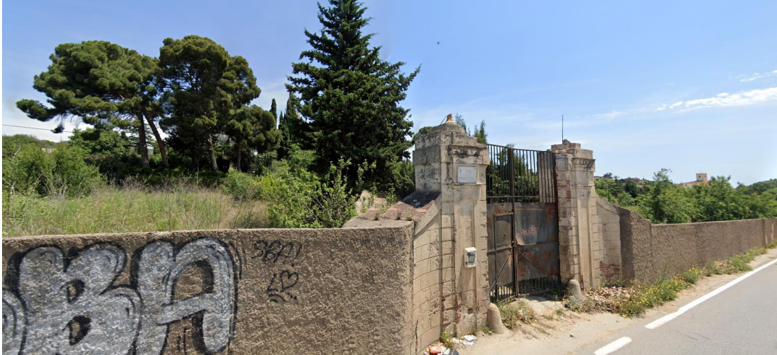
Vista general des d'un vial proper a l'àmbit.
