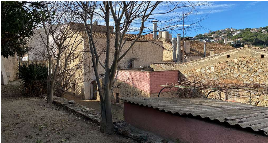
Imatge del sub-àmbit carrer Gurri des del nivell superior. Edificació existent queda a la dreta de la imatge. Font: Pròpia.
