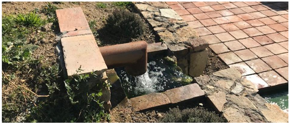
Mina d'aigua a l'àmbit de Can Bernades.
