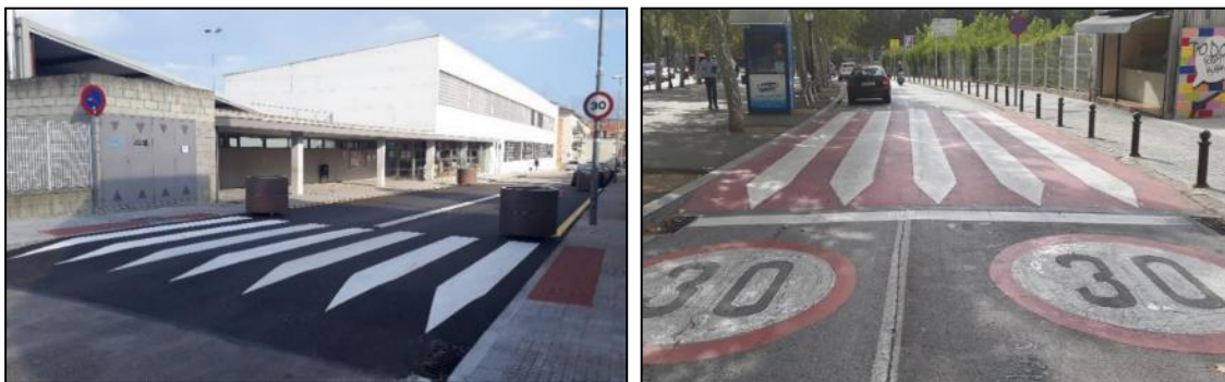
Figura 85. Exemple de plataforma en secció de carrer
